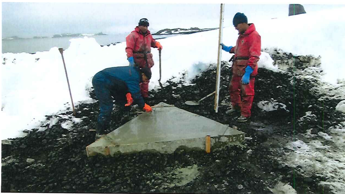
Cimentación de la base para la enfilada E-1
