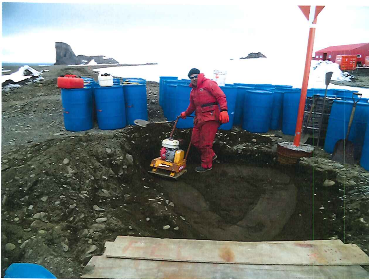
Preparación del terreno para la base de la enfilada E-2
