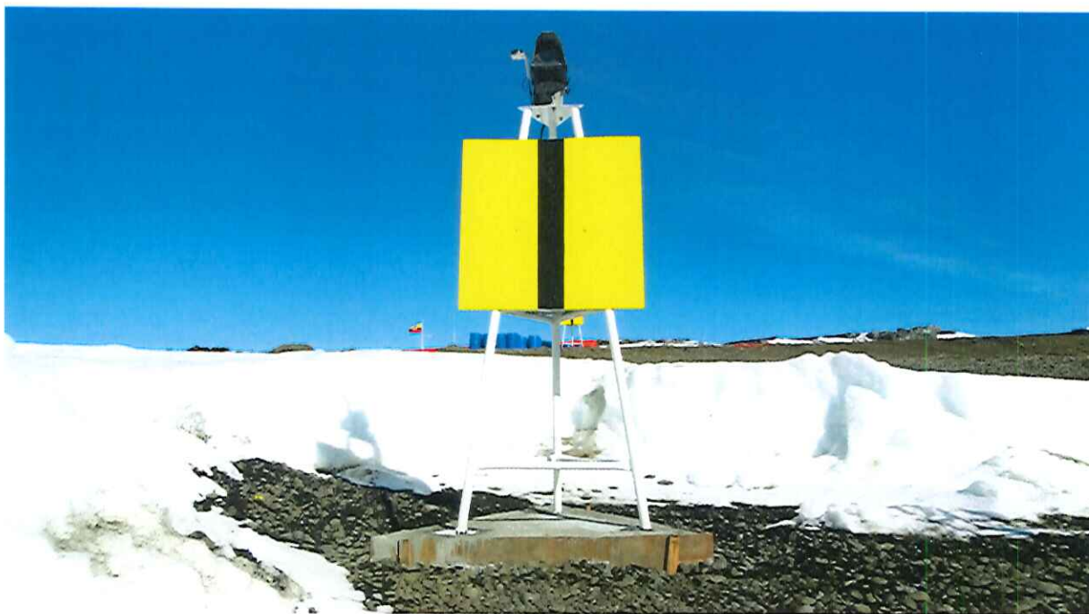
Color característico e instalación del equipo lumínico a la enfilada E-1
