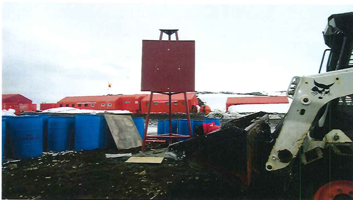
Instalación de la estructura para la enfilada E-2
