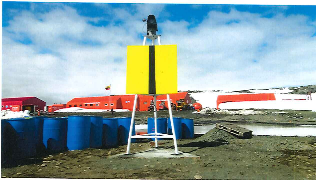
Color característico e instalación del equipo lumínico a la enfilada E-2
