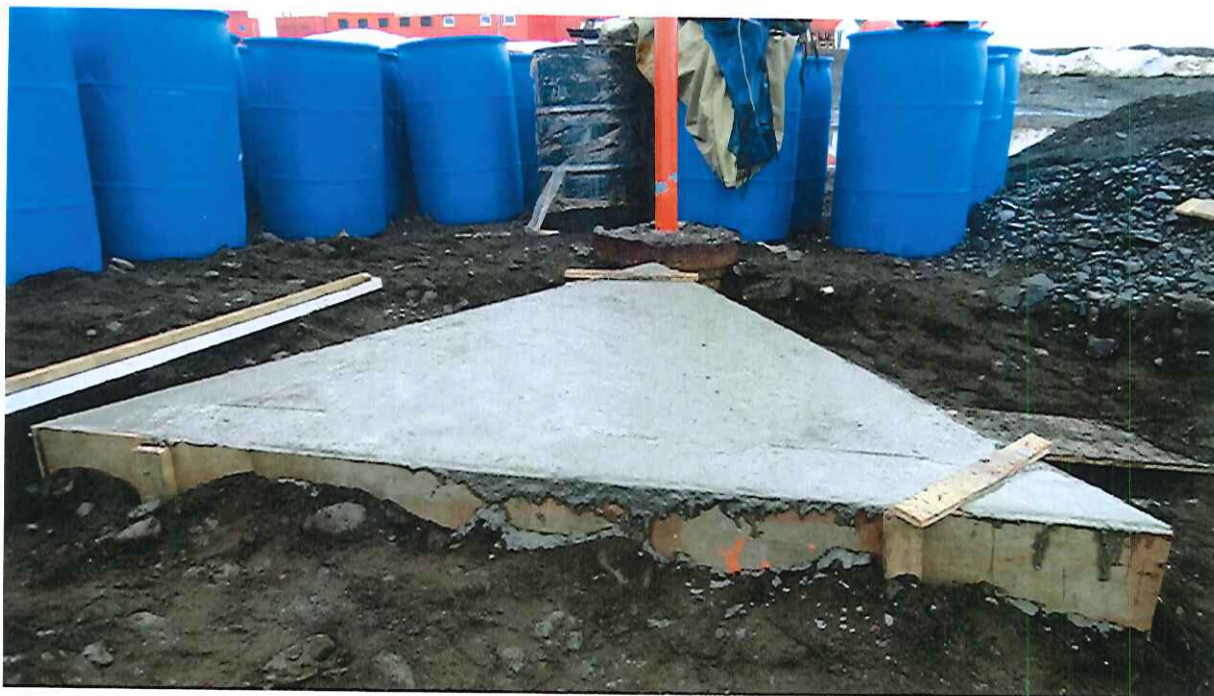
Cimentación de la base para la enfilada E-2
